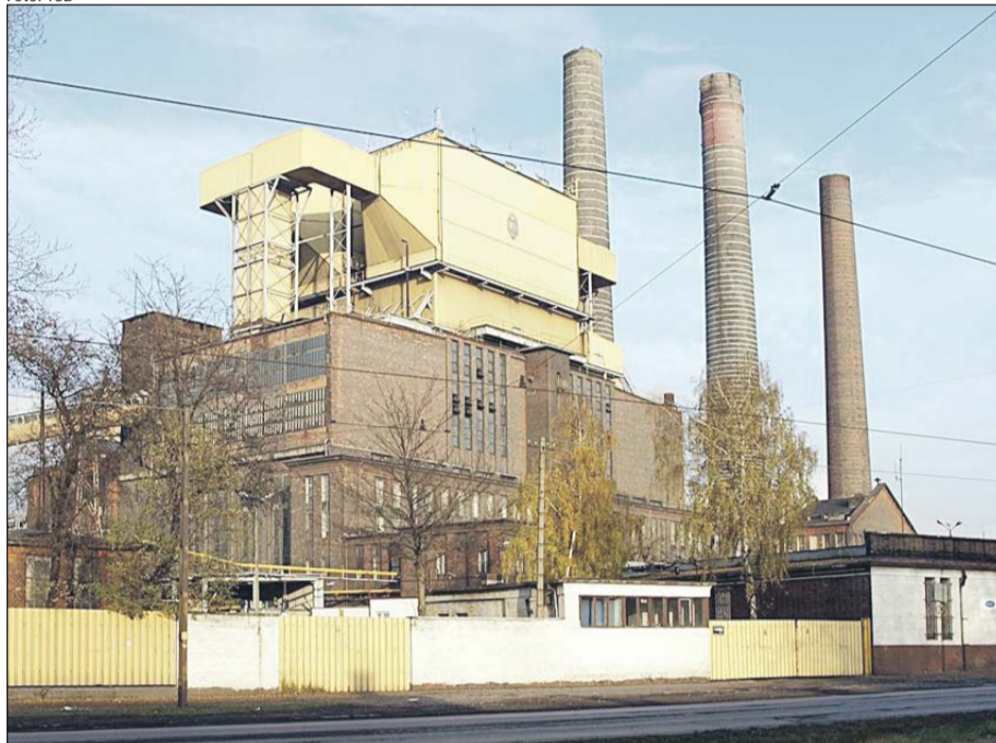
Cięcia oznaczają, że pracę straci co trzeci pracownik i tak już okrojonej w wyniku poprzednich zwolnień załogi
